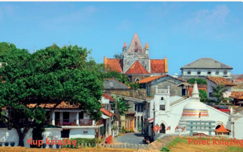
Zabudowa fortu w Galle
